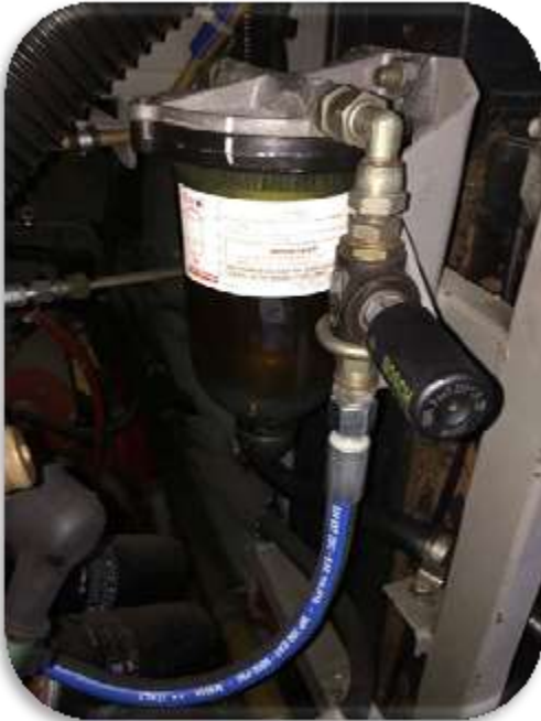
Changement du décanteur à Gasoil
